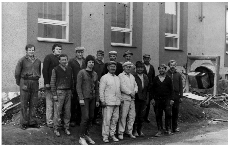
Mezice, r. 1979, rekonstrukce sálu
