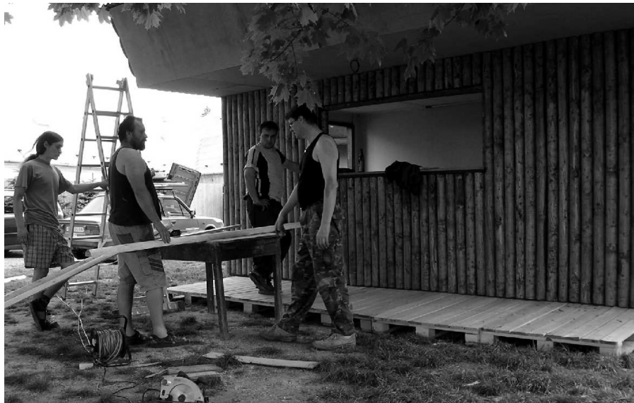
Mezice, r. 2007, oprava kiosku na hřišti
