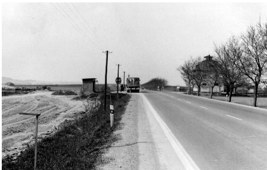
Mezice, r. 1981, stavba dálnice
