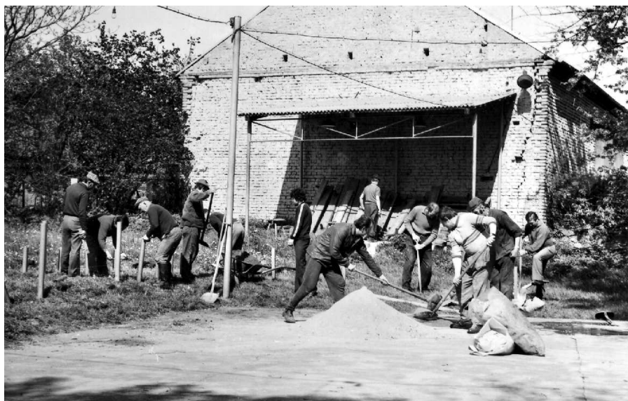
Mezice 16.5.1980, budování laviček na hřišti
